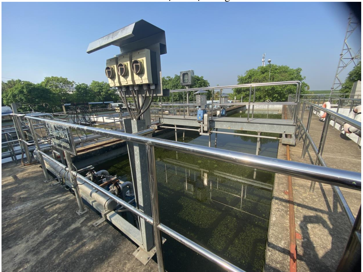
Bể lắng sơ cấp
